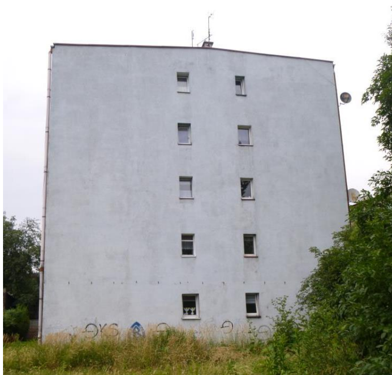
Rys. 4. Widok ogólny budynku przy ul. Szybowej 10 w Chorzowie – elewacja boczna (południowa) [1.4.].
