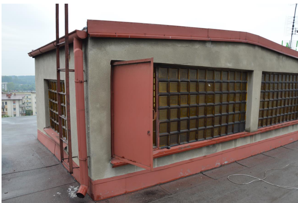
Rys. 6. Naświetle dachowe oraz wyjście na dach [1.4.].
