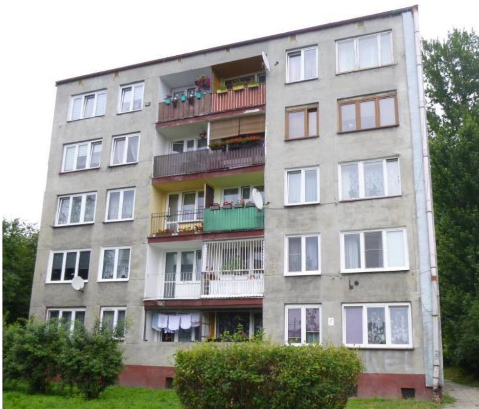
Rys. 3. Widok ogólny budynku przy ul. Szybowej 10 w Chorzowie – elewacja tylna (zachodnia) [1.4.].
